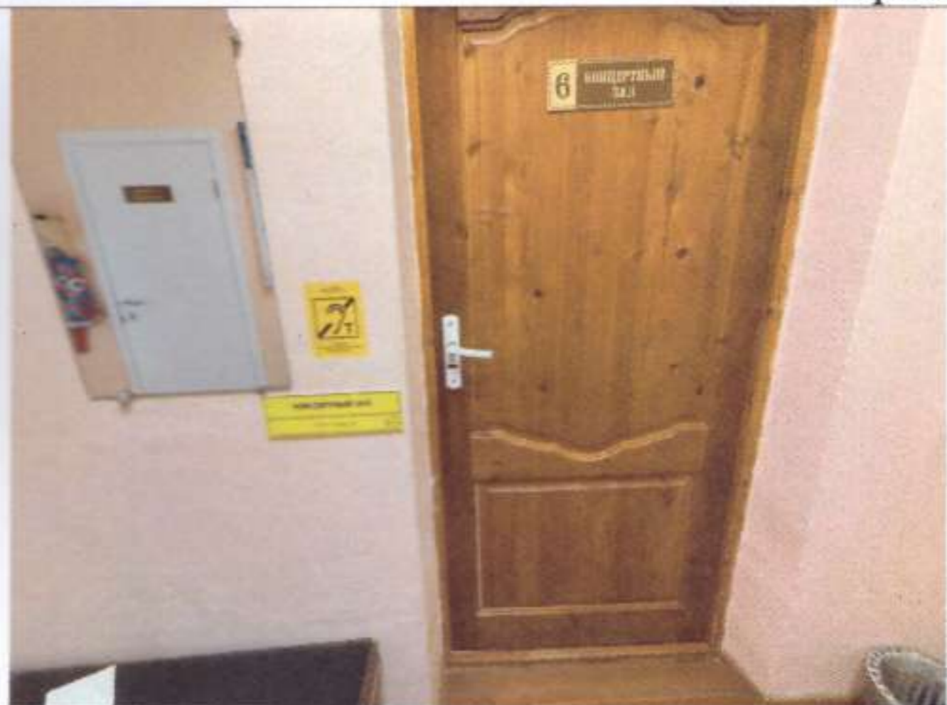
Фото №19 – Пути движения внутри здания (двери). Тактильная табличка с шрифтом Брайля (название кабинета)
