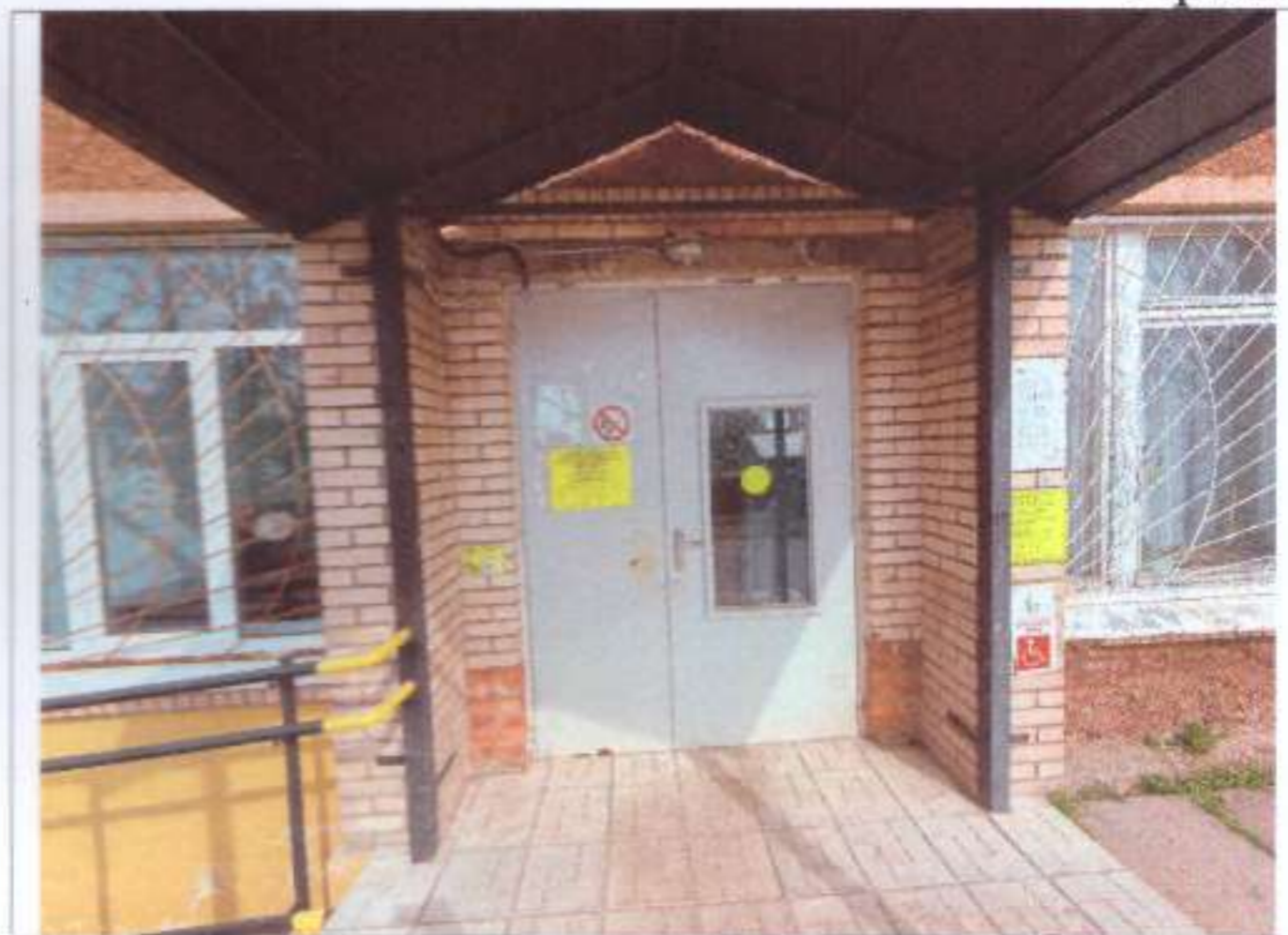
Фото № 7 – Входная площадка.
