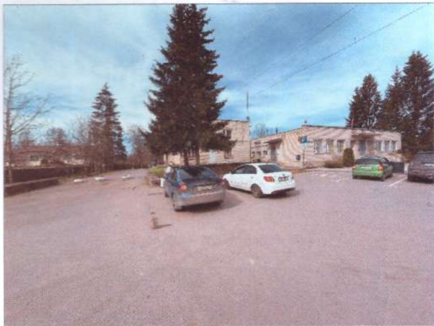
Фото № 1 – Подходы к объекту
