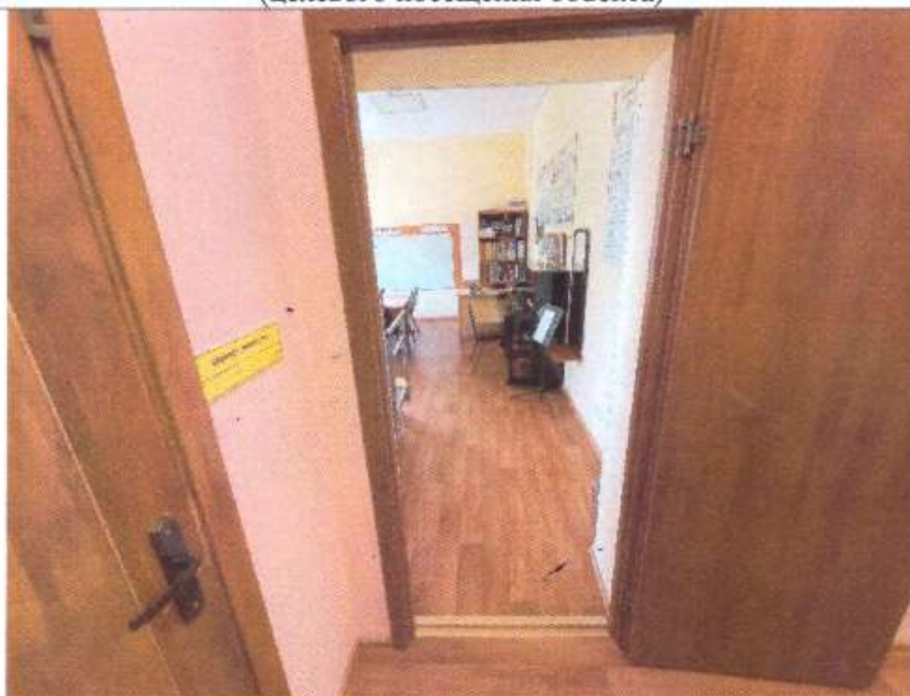
Фото № 22 – Пути движения внутри здания (двери). Тактильная табличка с шрифтом Брайля (название кабинета)
