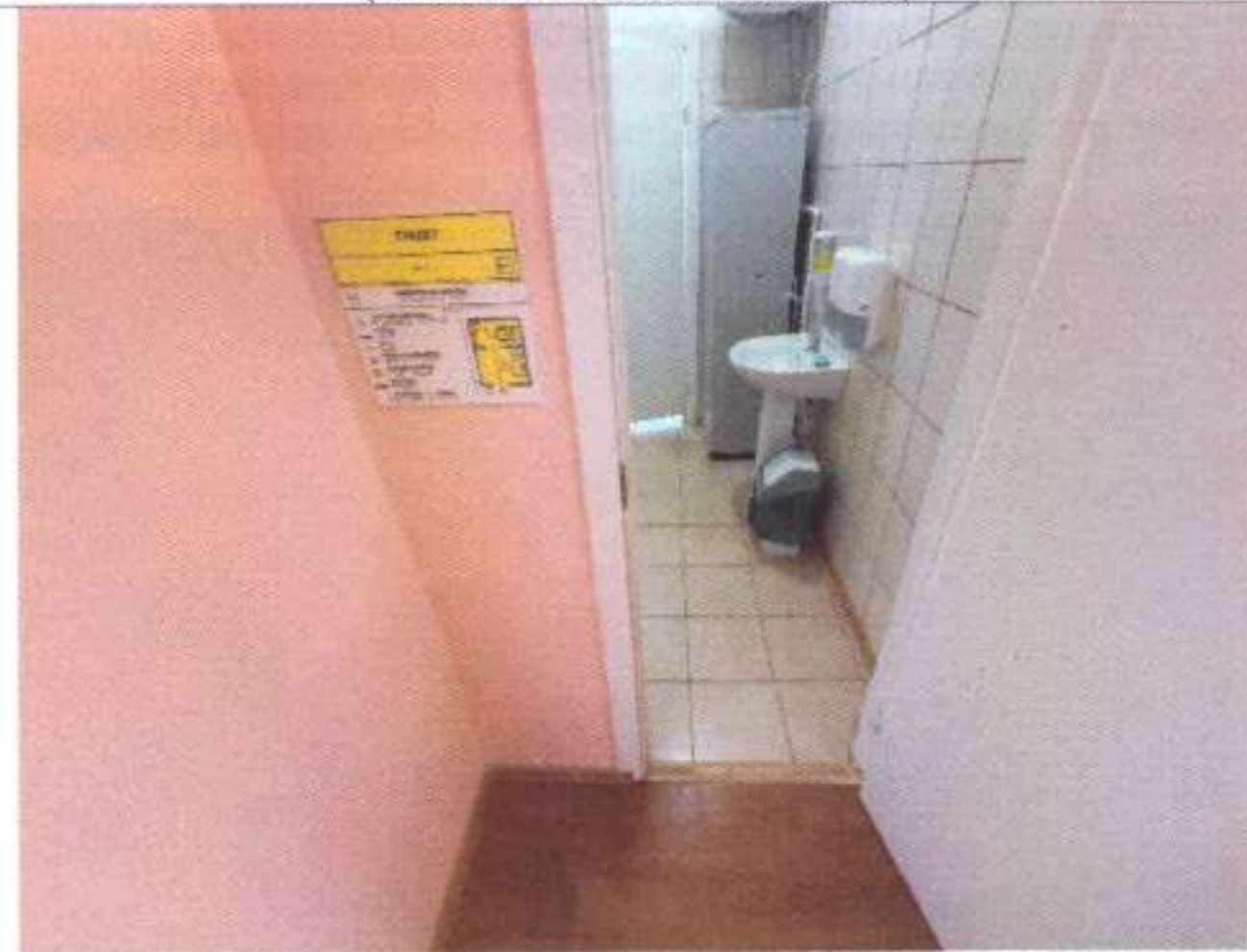
Фото № 30 – Санитарно-гигиенические помещения.
