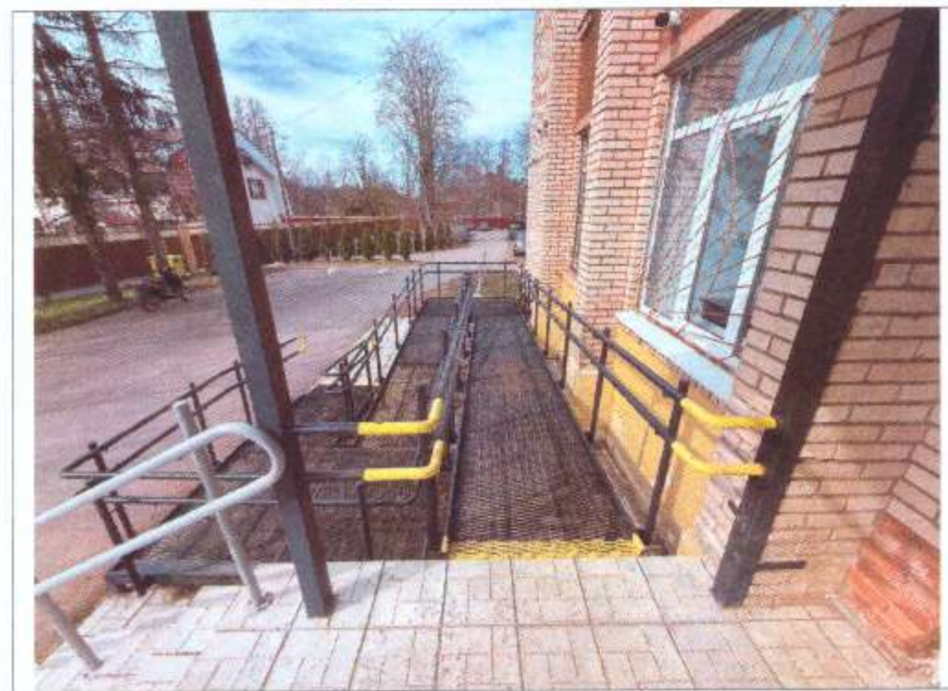
Фото № 6 – Пандус. Контрастно выделено начало и конец марша пандуса, а также начало и конец поручней.
