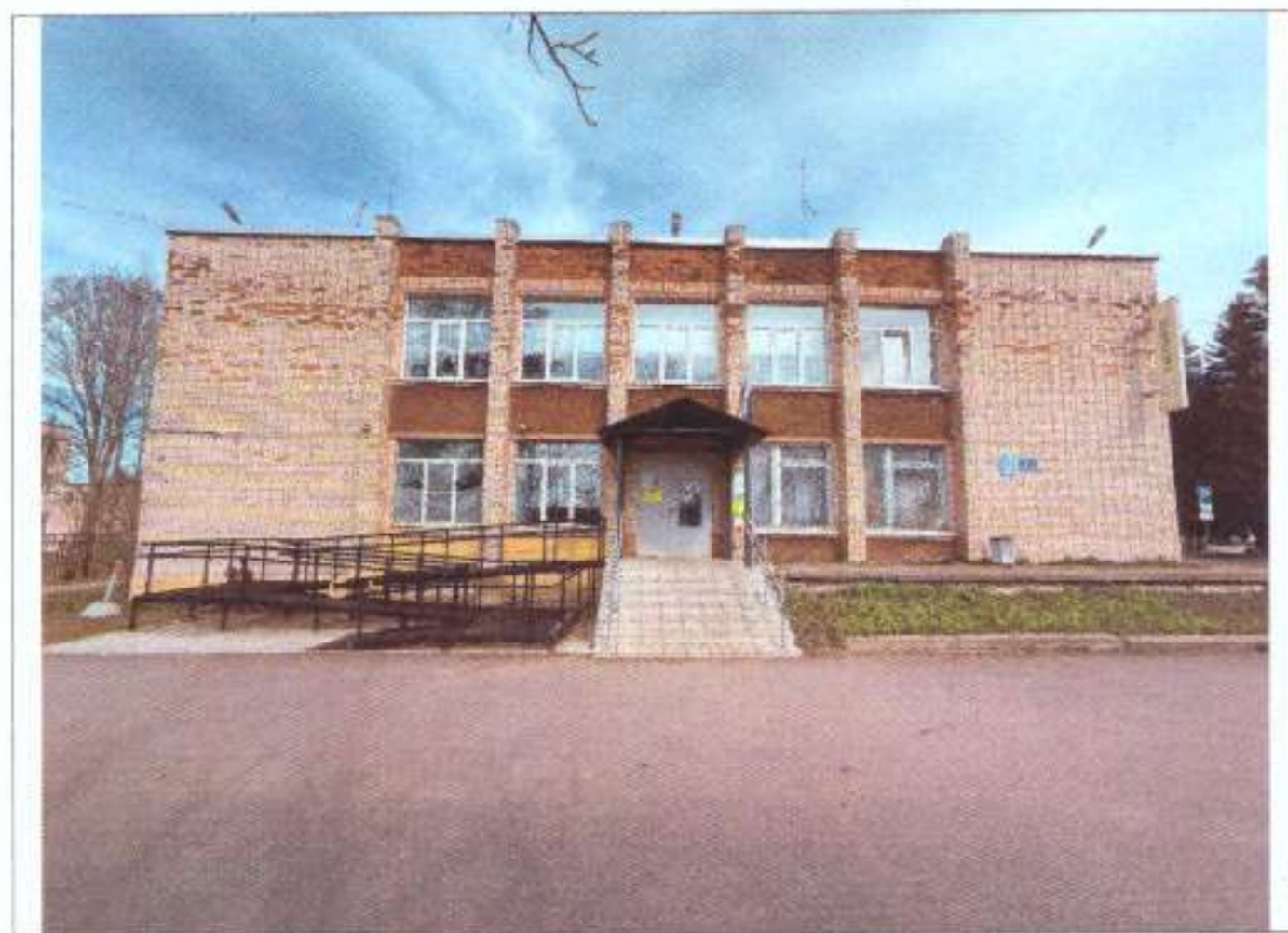
Фото № 3 – Входной узел.
