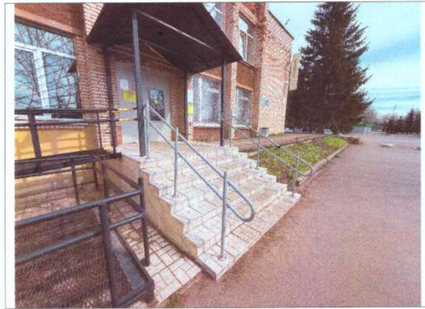
Фото № 4 – Наружная лестница.
